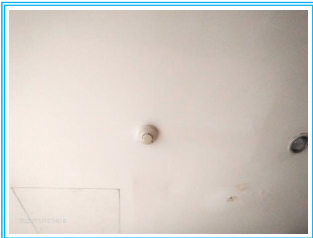
รูปที่ 2.5-10 เครื่องตรวจจับควัน
